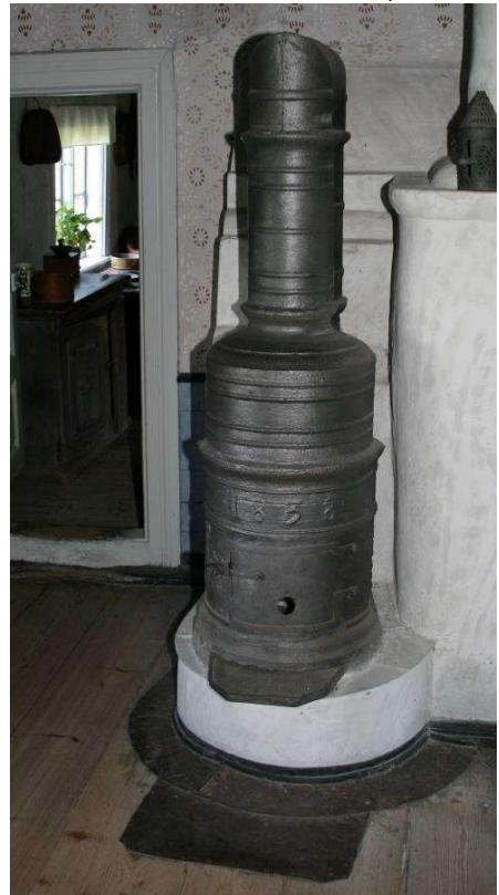
Bergslagskamin – verden ældste type af støbejernsovn. Tyndt støbejern uden udmuring. Denne er fra 1700-årene, men nyfremstilles af Jerle Bruk (17-20.000 SEK) – Siggebohyttan under Örebro Museum
